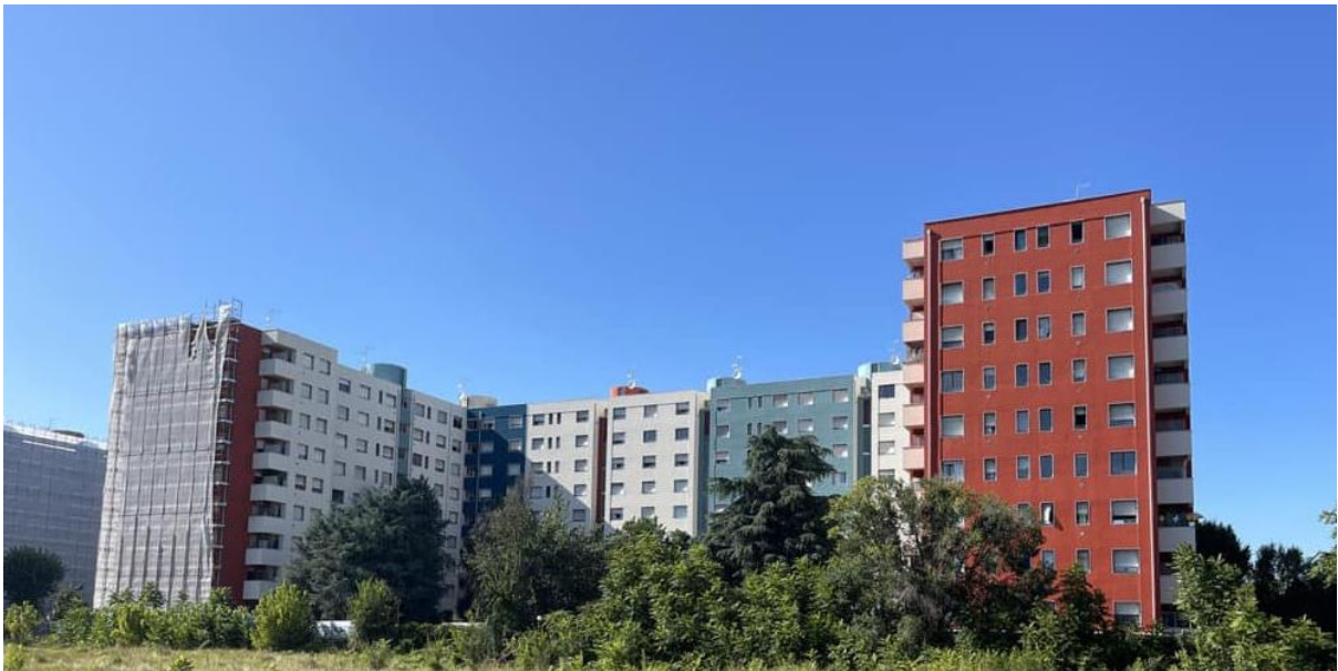
Nella foto gli edifici di via Salomone, in fase di conclusione dell'intervento di efficientamento
